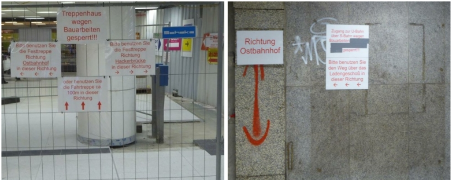
Im Februar 2015, also fünf Monate nach der feierlichen Eröffnung des umgebauten Zwischengeschosses besteht immer noch Baustellenatmosphäre.
