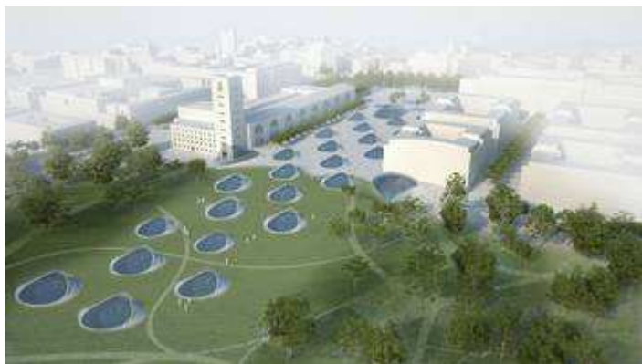
Schlechtes Vorbild hinsichtlich Pleiten und Pannen: Tiefbahnhof Stuttgart 21. Foto: DB
