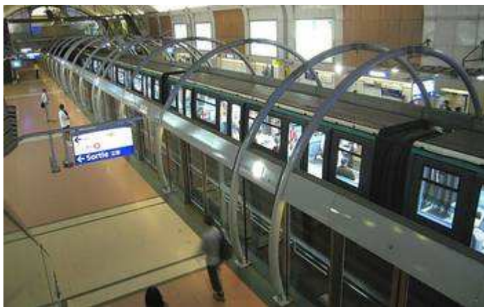
Bahnsteigtüren in der Pariser Métro. Foto: Pline
