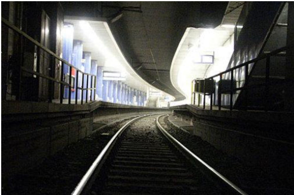
S-Bahn-Tunnel auf der Stammstrecke in München Foto: Mike Schmalz
