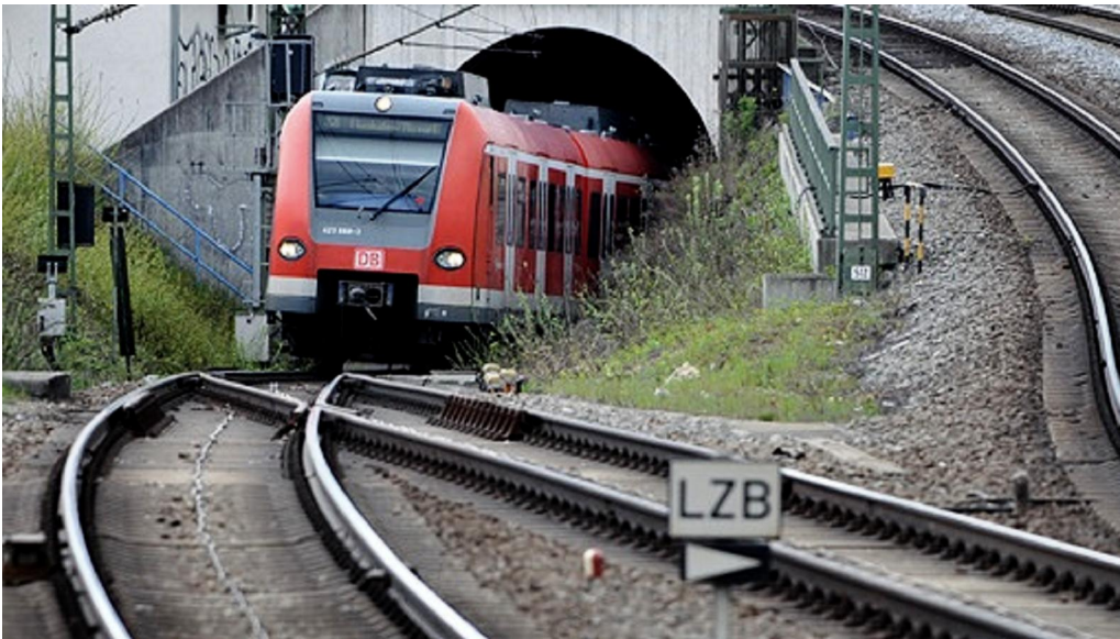
Zweiter S-Bahn-Tunnel: Kostenexplosion wegen falscher Baupläne?
